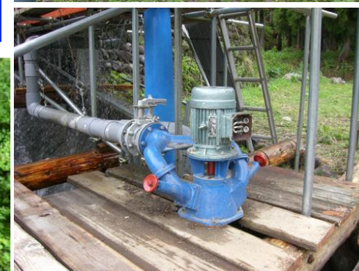
上：必要技術と普及障壁の検討のために実装した低落差型（上掛け水車）、下：高落差型（下、ターゴインパルス水車）の発電設備
