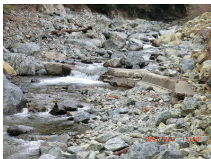
洪水で破損した取水堰、稲作ができなくなった。災害防止、荒廃抑制には、「地の知」をもつ地域管理者が不可欠
