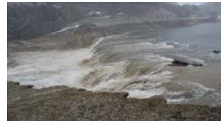
2011年東北地方太平洋沖地震で決壊する大規模ため池
